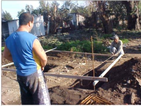
a. Replanteo de Bases y armado de zanjas
