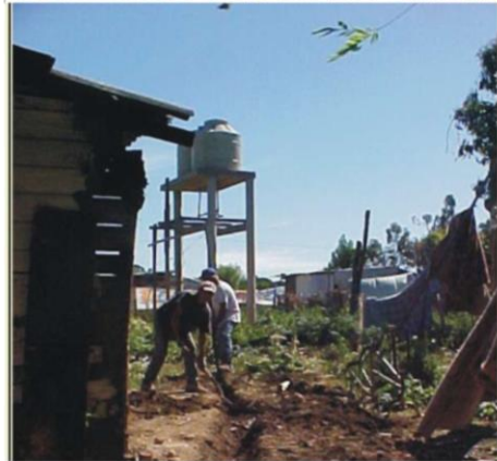
b. Tendido cañería
