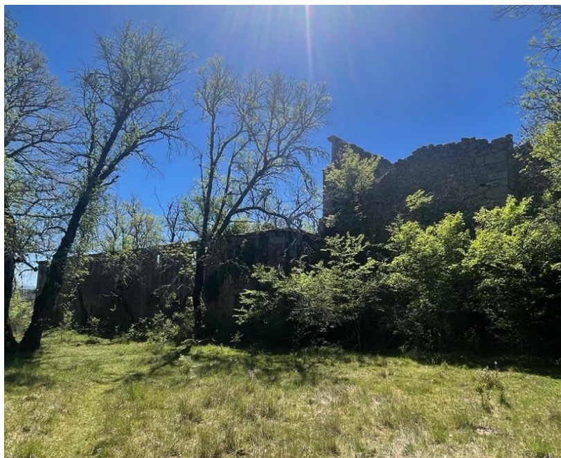
Figura 4. Ala este del monasterio. En la parte más oriental aún puede diferenciarse en altura, la primitiva iglesia del espacio monacal. Fotografía del autor ©
