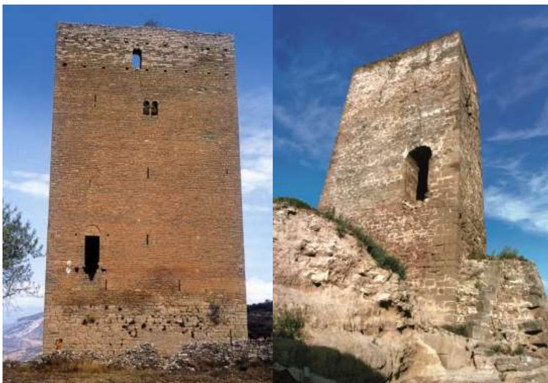
Figura 13. Abizanda (Huesca). Castillo. Torre. Exterior. Cara sur. Figura 14. Ardèvol (Lérida). Castillo. Torre. Exterior. Cara sureste
