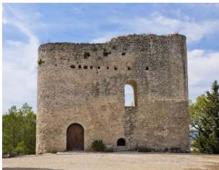
Figura 17. Tossa de Montbui (Barcelona). Castillo. Torre. Exterior. Cara este
