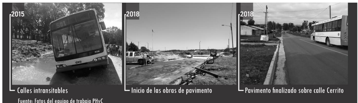
Figura 3 Estado inaccesible de la calle Cerrito. Fuente: Fotos del equipo de trabajo PHyC
