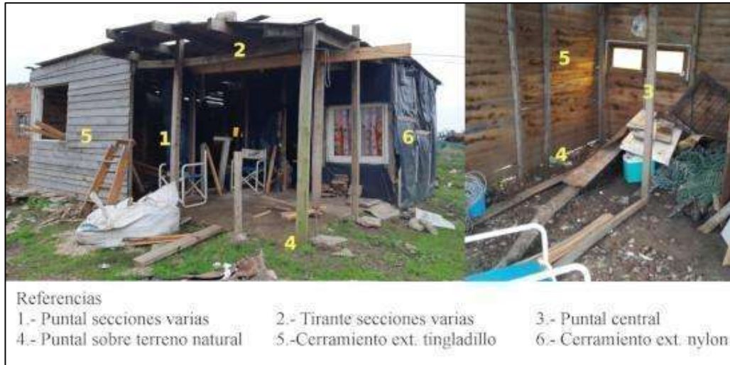
Figura 2. Sistema estructural y de cerramiento de casilla precaria
